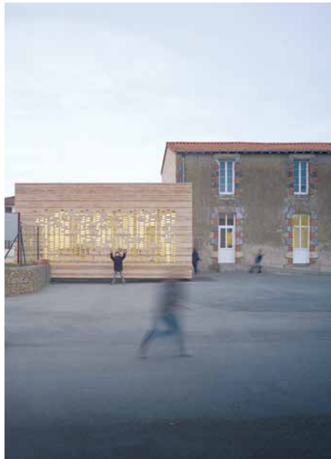
Extension mairie Chaillé-sous-les-Ormeaux, Vendée. © Photos Julien Lanoo.
